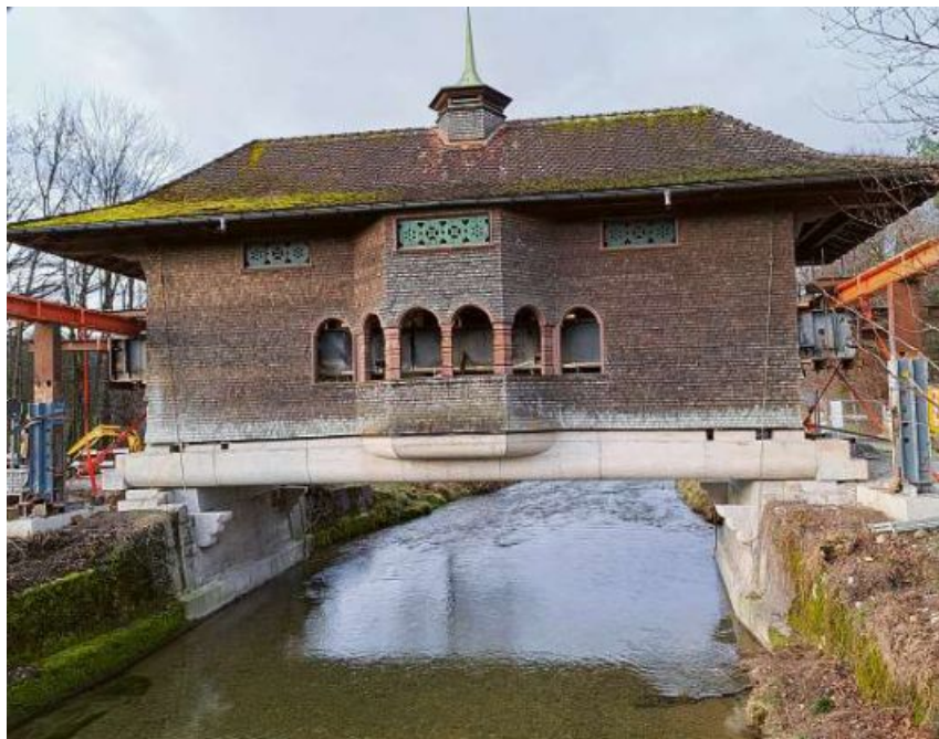
Bald wieder befahrbar: Die Bauarbeiten bei der Aabachbrücke in Schmerikon neigen sich ihrem Ende zu. Bild zVg
